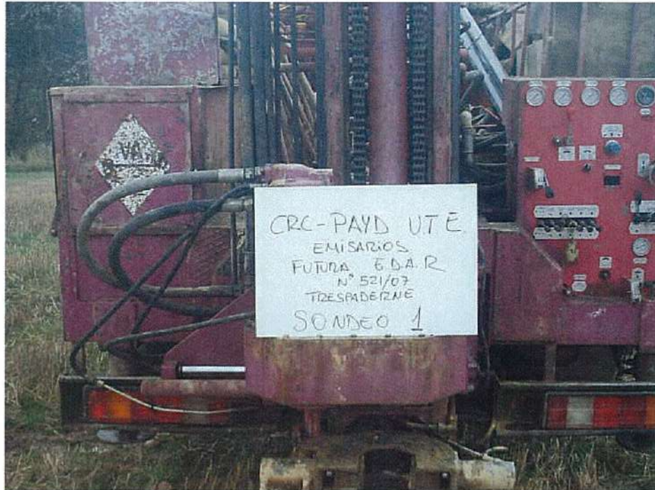
MAQUINA DE PERFORACIÓN INSTALADA EN EL SONDEO S-1
