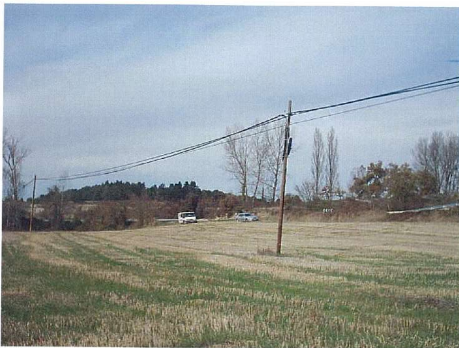
VISTA GENERAL DE LA ZONA DONDE SE INSTALARÁ LA FUTURA EDAR DESDE EL NORTE
