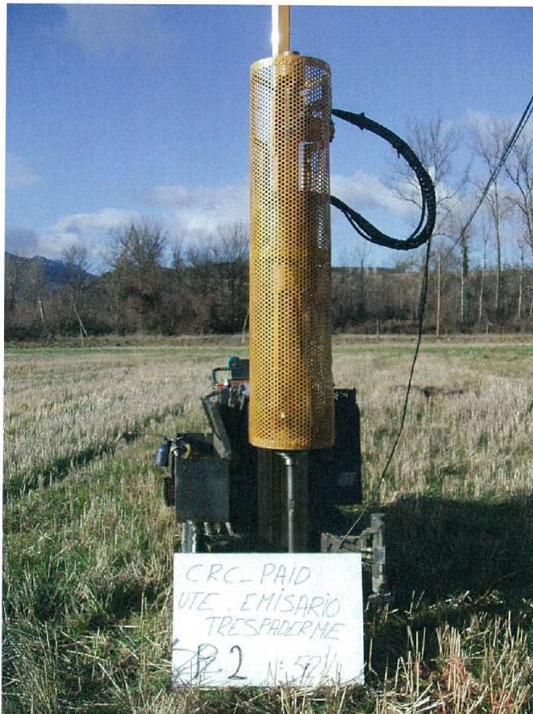
ENSAYO DE PENETRACIÓN DINÁMICA D.P.S.H. N° 2
