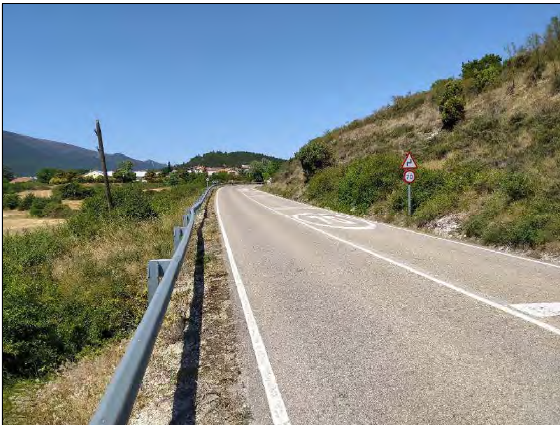
Foto n°9. Carretera BU-530. Entrada a localidad de Trespaderne.
