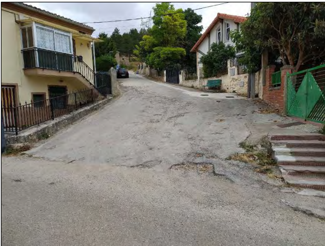
Foto n°3. Calle La Cuesta. Inicio de tramo.
